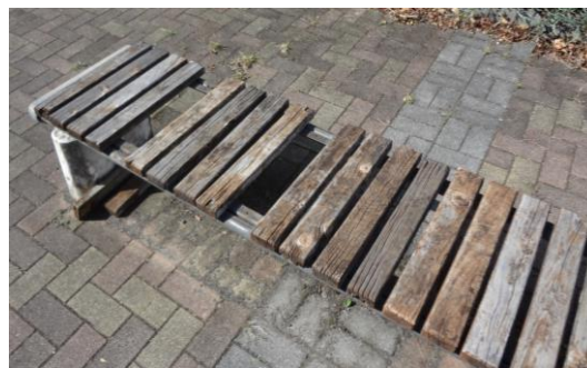
【座る部分が朽ちてしまったベンチ】
